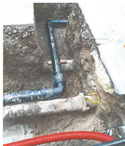
Dévoiement canalisation GRDF
